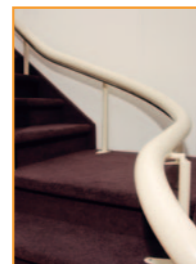
Für den Außenlauf der Treppe
